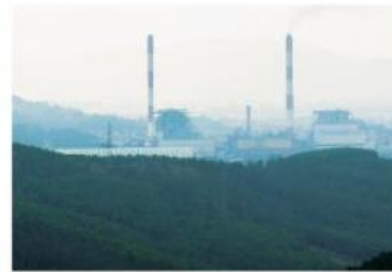
▲ Hình 10.8. Nhà máy nhiệt điện
